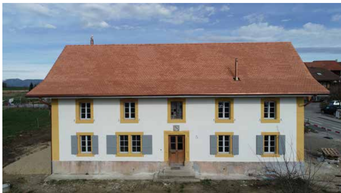
En cours de rénovation 2018 - 2019
