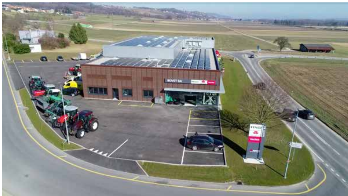
Le nouveau bâtiment terminé en 2018 et inauguré en 2019
